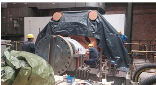
Montaža motorja AC v SIJ Acroniju
