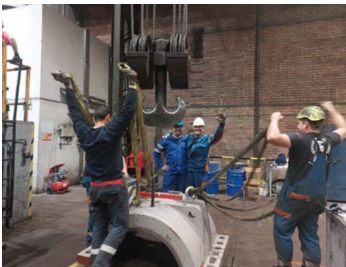
Zmagoslavje sodelavcev družbe SIJ Acroni in Elektroremonta pri zapenjanju pokrova aksialnega ležaja motorja.
